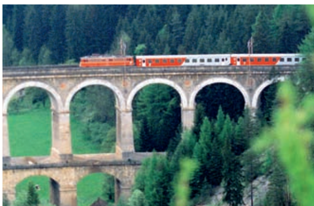
Weltkulturerbe Semmeringbahn: Neuer Tunnel soll Entlastung bringen.
